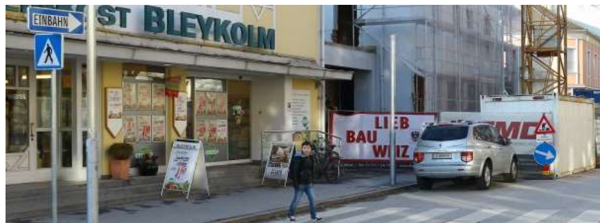
Die Baustelle gegenüber der Schule erfordert auch Umwege zu Fuß: es staubt sehr und ist laut
